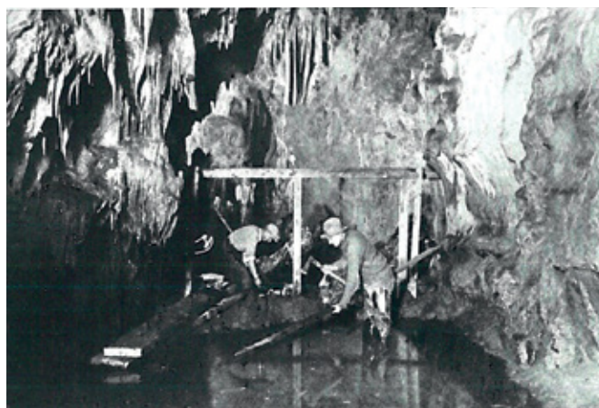
Obr. 2. Stavba provizórnej hrádze Prvej plavby v roku 1932. Foto: V. Benický, Archív ochrany prírody a jaskyniarstva
