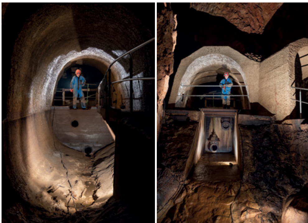
Obr. 7. Hrádza Prvej plavby z oboch strán. Foto: P. Staník Fig. 7. Dam of the First Boat Trip from both sides. Photo: P. Staník
