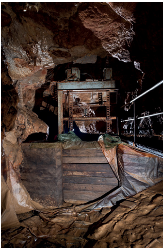
Obr. 6. Stavido hrádze Druhej plavby (súčasný stav). Foto: P. Staník Fig. 6. The sluice gate of the Second Boat Trip dam (present condition). Photo: P. Staník
