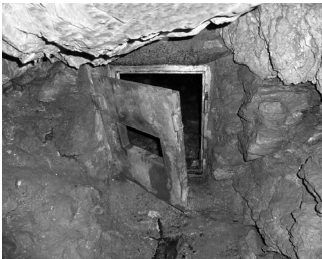
Poškodený uzáver v jaskyni Dupná diera. Foto: D. Čongrády
