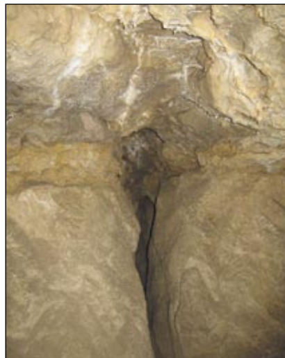
Obr. 13. Detail erozívneho rozhrania medzi podložnými mezozoickými dolomitmi a nadložnými paleogénnymi klastickými sedimentmi – staršie a krehkejšie mezozoické karbonátové horniny sú viac tektonicky porušené a viaže sa na ne väčšina priestorov jaskyne. Naopak, brekcie borovského súvrstvia vytvárajú nad nimi akýsi len miestami porušený ekran – bariéru, pod ktorou fungovalo podzemné odvodnenie masívu. Foto: L. Vlček
