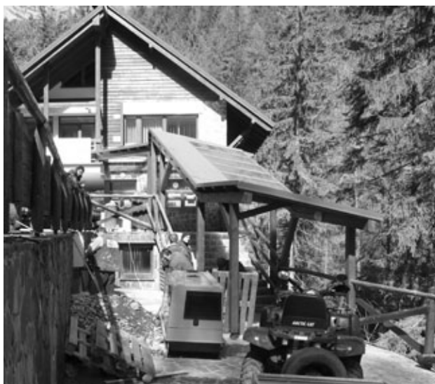
Inštalácia dieselového náhradného zdroja elektrickej energie na terase pred Belianskou jaskyňou. Foto: P. Gažík
