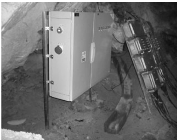
Výmena elektrických rozvodných skriň. Foto: P. Stankoviansky
