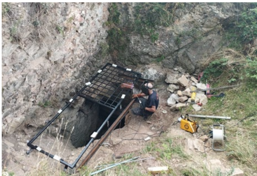
Inštalácia uzáveru Divínskej hradnej jaskyne. Foto: K. Kýška
