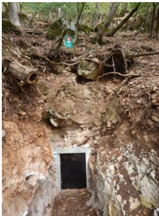
Úprava vchodu do Hrušovskej jaskyne. Foto: I. Balciar
