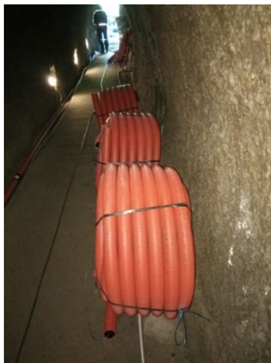
Práce vo vstupnej štólňi. Foto: P. Stankoviansky
