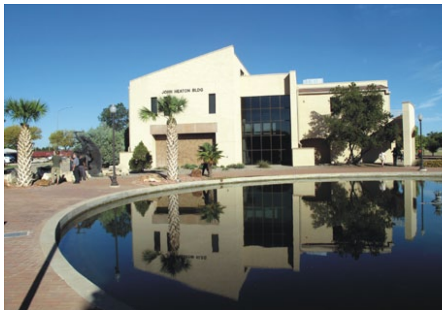
Budova NCKRI v Carlsbade. Foto: P. Bella
