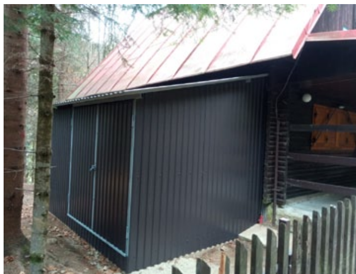
Prístrešok pre náhradný zdroj. Foto: P. Stankoviansky
