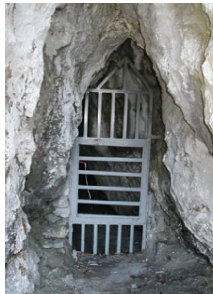
Obr. 4. Mrežový uzáver spodného vchodu, apríl 2002. Foto: P. Bella
