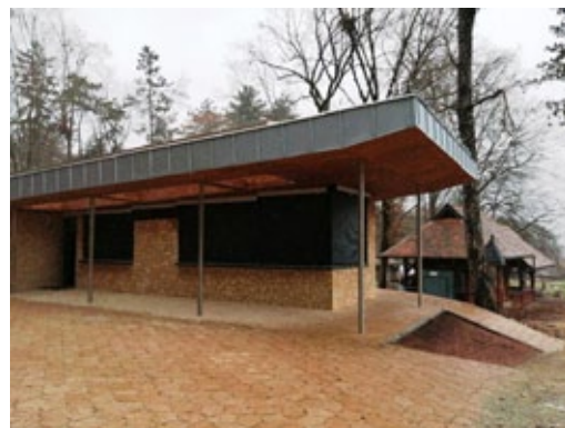
Predná časť novej prevádzkovej budovy Gombaseckej jaskyne. Foto: P. Rendko
