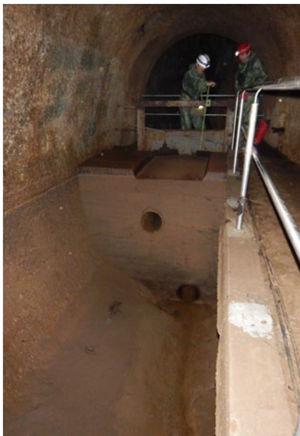
Obr. 20. Umelá hrádza v závere nádrže I. plavby na podzemnom toku Styx. Foto: D. Haviarová
