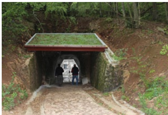
Vchod do štôľne so strechou s vegetačným krytom. Foto: L. Gaál
