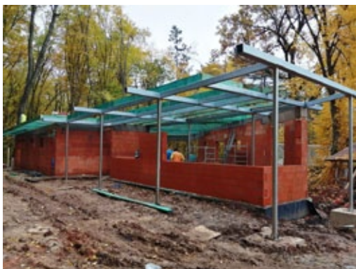
Výstavba prevádzkovej budovy Gombaseckej jaskyne. Foto: P. Rendko
