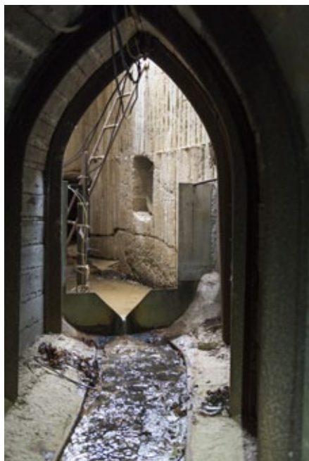
Obr. 3. Merný priepad v ponore Domického potoka. Foto: P. Staník Fig. 3. The water-gauging station in the ponor of the Domický potok Creek. Photo: P. Staník
