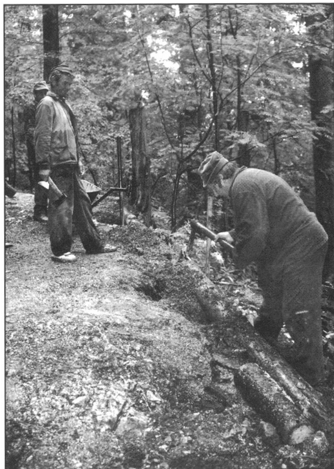
Úprava starého chodníka k Dobšinskej ľadovej jaskyni.
