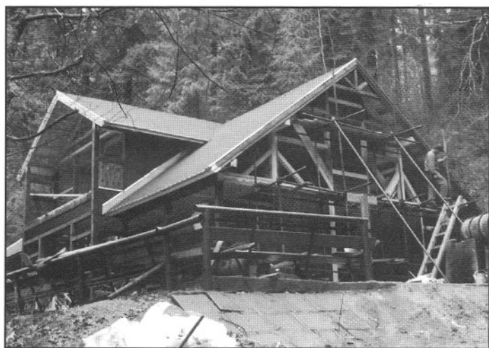
Výstavba vstupného objektu Dobšinskej ľadovej jaskyne.
