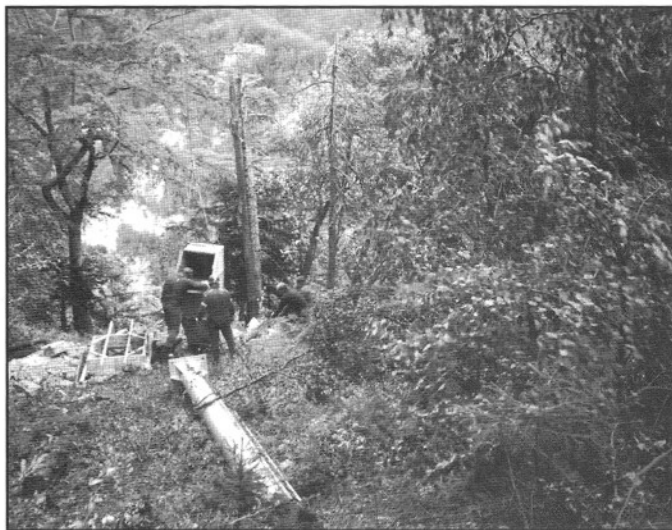
Výstavba lanovky k Harmaneckej jaskyni.
