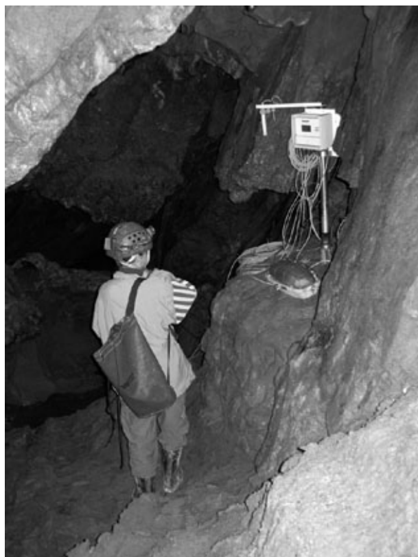
Obr. 5. Monitorovací stacionár na Čiernom potoku v Gombaseckej jaskyni. Foto: P. Staník
