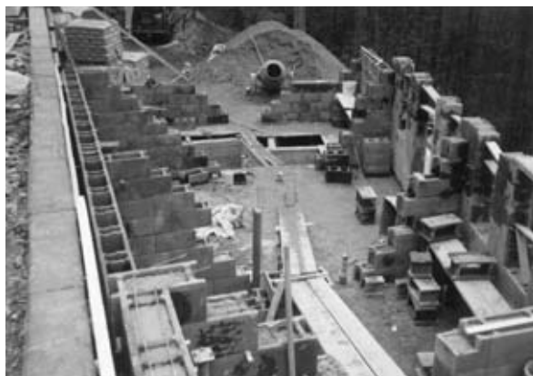
Budovanie oporného múra a hygienických zariadení. Foto: J. Peška
