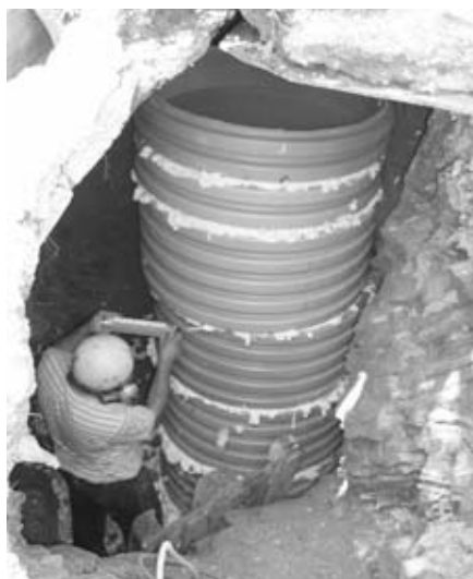
Obr. 2. Inštalovanie plastových rúr v Priepasti v Kavečanoch, začiatok júla 2010. Foto: V. Papáč
