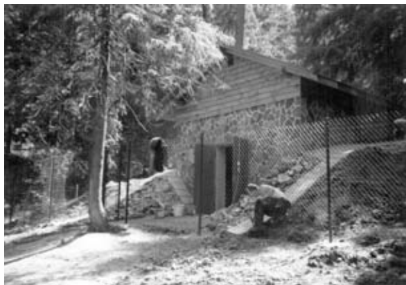
Objekt prečerpávacej stanice. Foto: J. Peška
