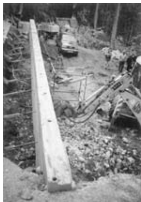
Budovanie oporného múra a hygienických zariadení. Foto: J. Peška
