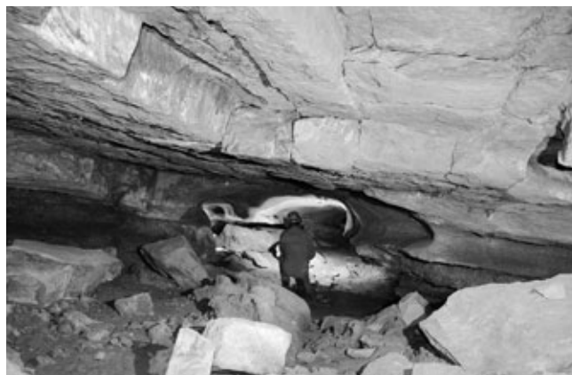
Obr. 5. Tomášovská jaskyňa, vypadávanie stropných lavíc v miestach širších chodieb. Foto: F. Mihál'
