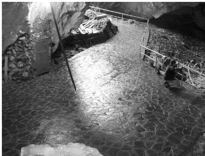
Úprava prehliadkového chodníka vo vstupnej časti Harmaneckej jaskyne. Foto: P. Labaška
