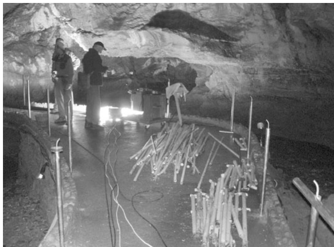
Výmena zábradlia na prehliadkovej trase v Demänovskej jaskyni slobody. Foto: P. Labaška
