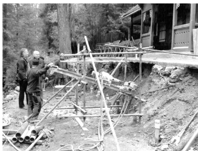
Zakladanie stavby sociálnych zariadení a terasy pilótami v areáli Dobšinskej ľadovej jaskyne, október 2008. Foto: J. Hlaváč
