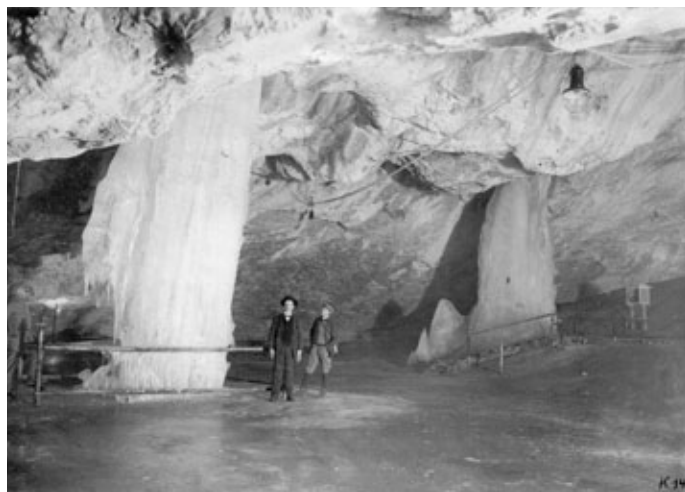
Obr. 7. Oblúkové lampy na stropie Veľkej siene. SMOPaj, Liptovský Mikuláš Fig. 7. Arc lamps on the ceiling of the Great Hall. SMOPaj, Liptovský Mikuláš
