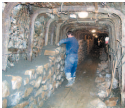
Kamenná vyzdívka v nové štole. Foto: K. Drbal
