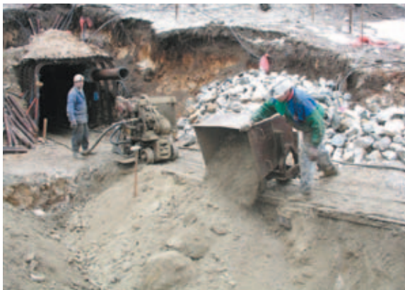
Ražba výstupové štoly. Foto: K. Drbal
