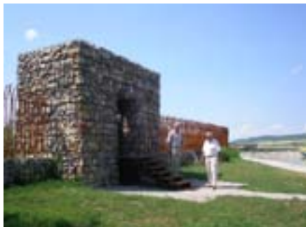
Vstup do objektu Morského oka. Foto: P. Gažík
