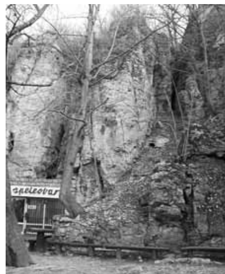
Obr. 10. Tektonické poruchy náchylné na gravitačné svahové pohyby, skalný útvar pri vchode do jaskyne Driny. Foto: P. Bella
